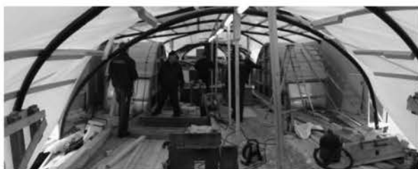
Bra arbetsklimat under täckningen
