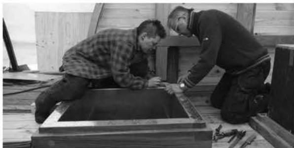
Kotten & Uddo jobbar med att klä in vednedkastet
