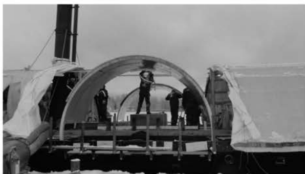
Arbete med hjulhusen
