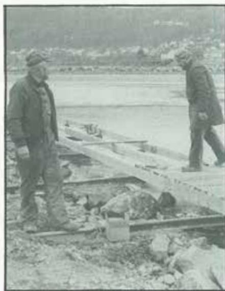
Bryggförlängning byggdes år 1986. Ett gäng JSS:are var flitiga med byggnationen. Här diskuterar slipmästaren Robert Karlsson och Arne Svensson hur de ska fortsätta jobbet.
