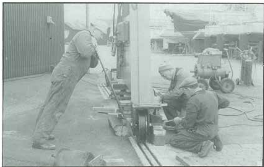
Kranen lyfts upp och hjulen svetsas fast. All rost har avlägsnats och den har fått ny färg. Fr. v. Ingmar Svensson, Björn Åstrand och Curt Adamsson.
