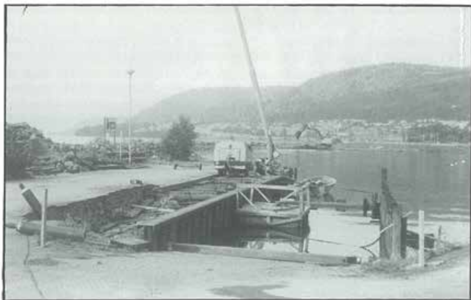
Arbetet i full gång med sjösättningsrampen. Stålspons har drivits ner på båda sidorna om den gamla rampen.
